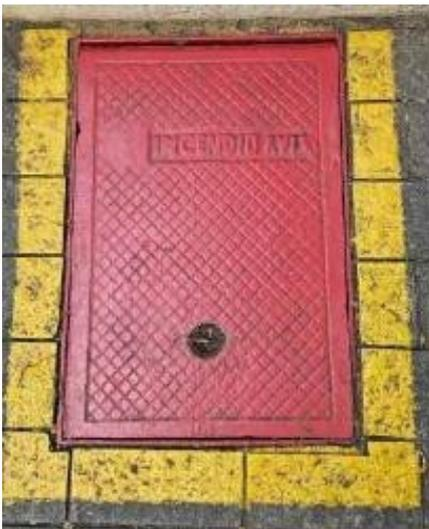
*Figura 25 Exemplo de pintura do hidrante de recalque*
