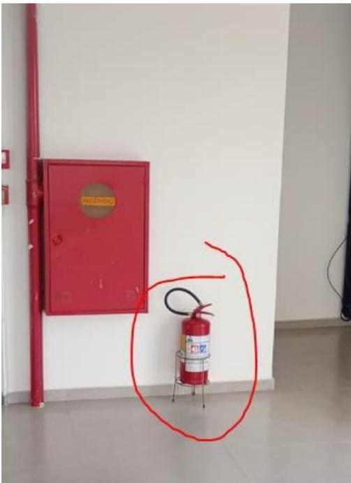
*Figura 18 Extintor em local diferente da placa*
