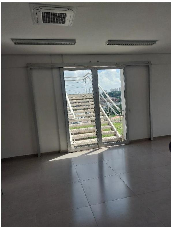
*Figura 5 Porta de saída sem iluminação de emergência*
