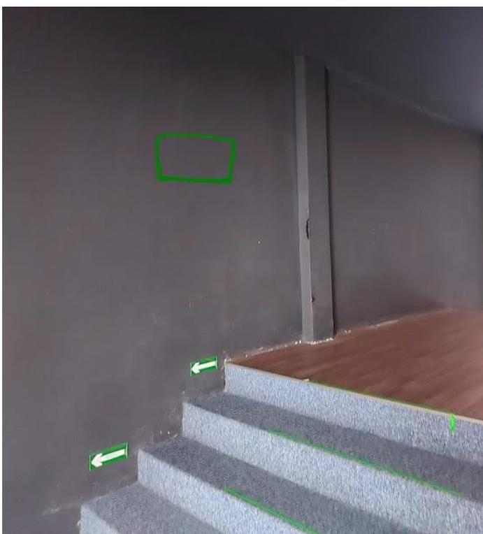
Figura 10 Escada sem placa de indicação
