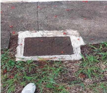
*Figura 24 Hidrante recalque atual*
