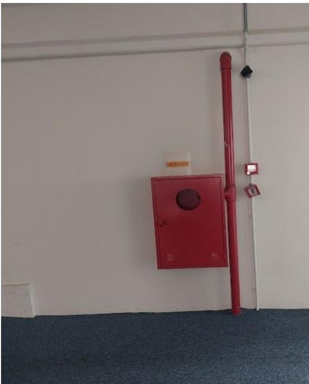
*Figura 15 Hidrante sem placa*
