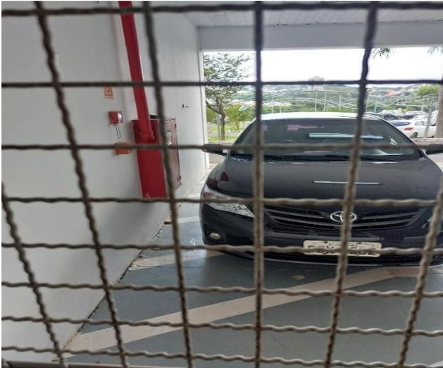
*Figura 23 Hidrante obstruído*
